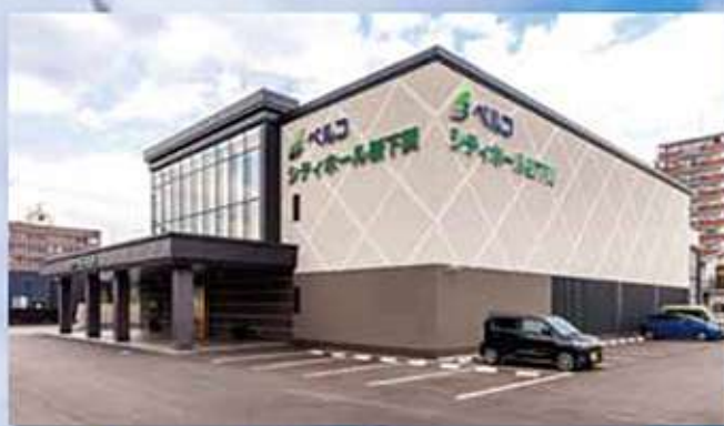
シティホール新下関 ベルコ会館
